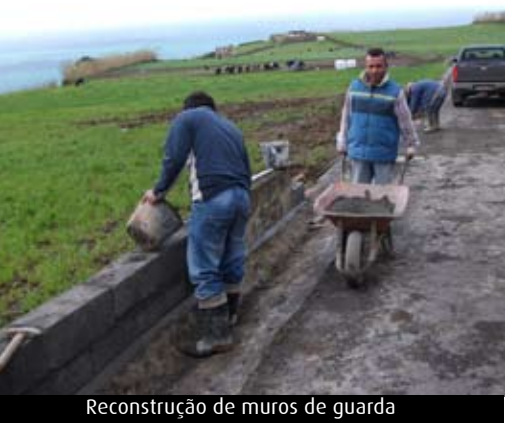
Reconstrução de muros de suporte
