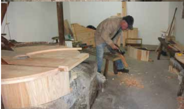
Reabilitação de património municipal (moinho do Parque Natural da Ribeira dos Caldeirões)
