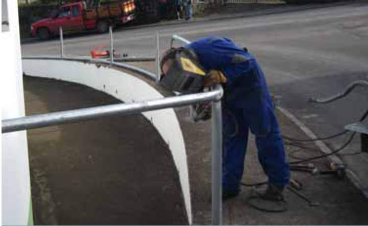
Colocação de guardas em arruamentos e passeios
