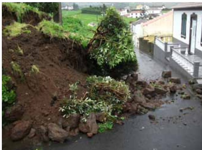
Queda de muro no Caminho do Calço na freguesia de Algarvia
