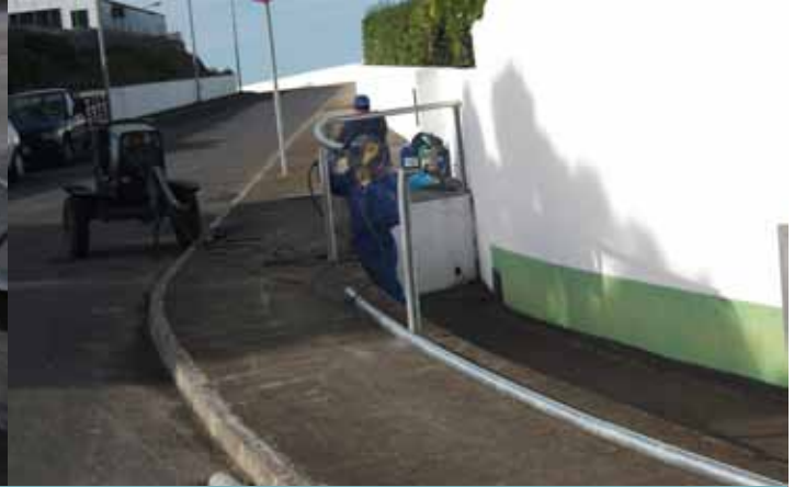
Colocação de guardas em arruamentos e passeios
