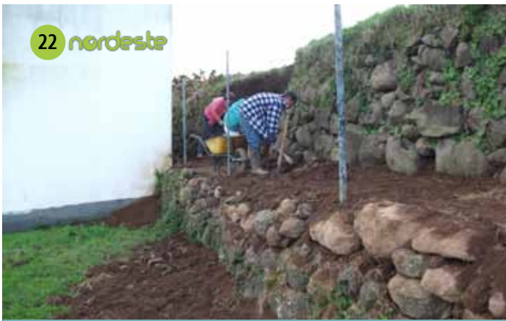
Recuperação de acesso público pedonal
