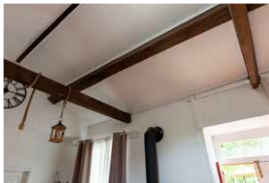
Reparação da armação e telhado do moinho da Ribeira do Guilherme – Vila do Nordeste
