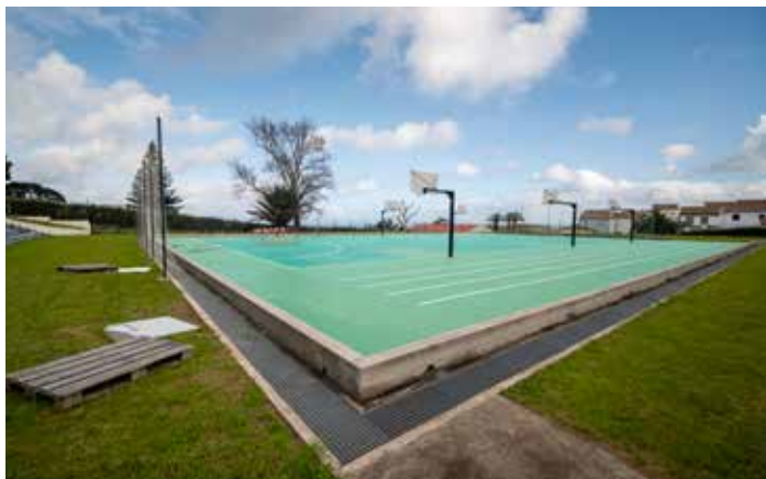
Manutenção das vedações e equipamentos desportivos do campo exterior da EBS do Nordeste
