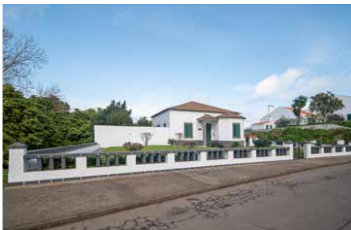
Reabilitação da Casa do Passal – Lomba da Fazenda
