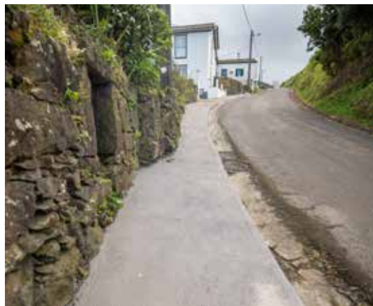
Reparação de passeios na Rua Abel Dinis – São Pedro
