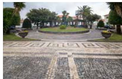
Continuação da reparação da joga no Jardim do Município - Vila do Nordeste
