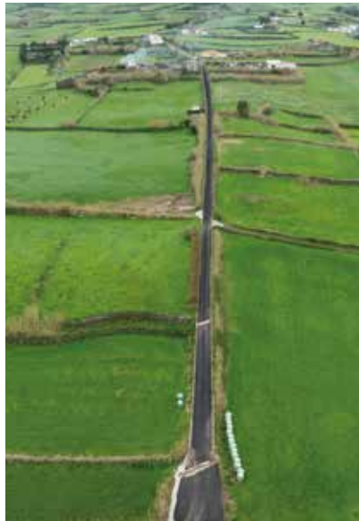
PAVIMENTAÇÃO DO CAMINHO DO CALÇO FAZENDA
