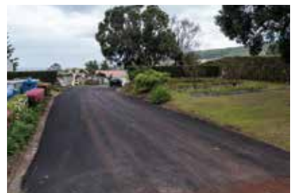
PAVIMENTAÇÃO DO PARQUE DE MAQUINAS DA CMN VILA DO NORDESTE
