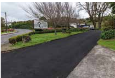
PAVIMENTAÇÃO NA LOMBA DA CRUZ DE BAIXO LOMBA DA FAZENDA
