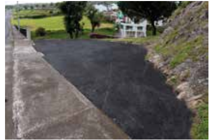
PAVIMENTAÇÃO DE ESTACIONAMENTO NA AVENIDA D. MANUEL I - VILA DO NORDESTE
