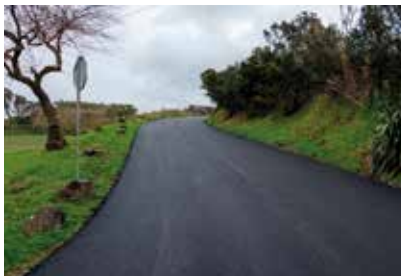
PAVIMENTAÇÃO DA RUA NOVA ACHADA
