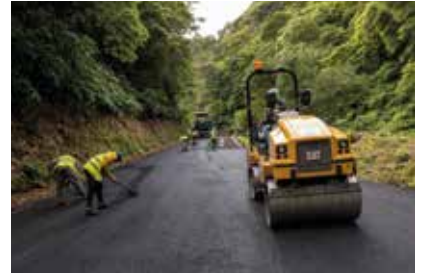
PAVIMENTAÇÃO DO CAMINHO DO LOMBO GORDO PEDREIRA
