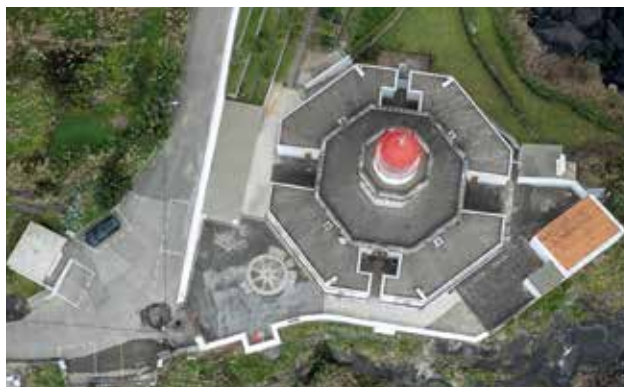
REPARAÇÃO DE PAVIMENTO E CALÇADA DO FAROL DO ARNEL VILA DO NORDESTE
