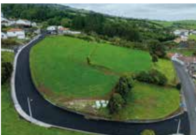
PAVIMENTAÇÃO E ARRANJO DOS PASSEIOS DA RUA DO ARREBENTÃO - PEDREIRA
