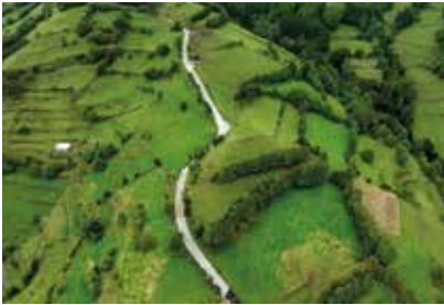
PAVIMENTAÇÃO DO CAMINHO DO PICO PEDREIRA
