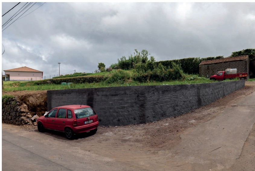
ALARGAMENTO DA RUA DO GEADA E CONSTRUÇÃO DE MURO DE SUPORTE - ASSOMADA SÃO PEDRO NORDESTINHO
