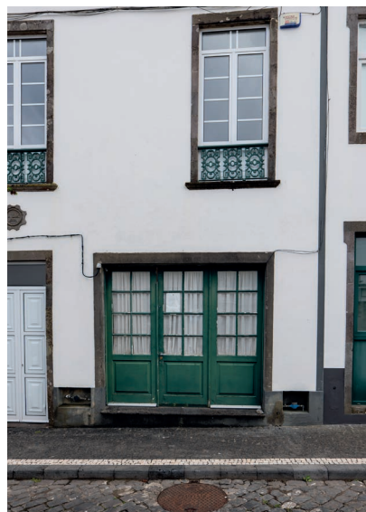
EMPREITADA DE REABILITAÇÃO DO ANTIGO MUSEU DO NORDESTE PARA INSTALAÇÃO DA EMPRESA MUNICIPAL NORDESTE ATIVO VILA DO NORDESTE
