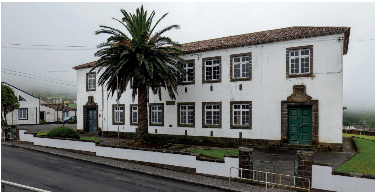
EMPREITADA DE ADAPTAÇÃO DE EDIFÍCIO PARA INSTALAÇÃO DA SEDE DA JUNTA DE FREGUESIA - ALGARVIA
